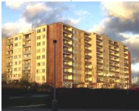
Vláda schválila nařízení o použití prostředků SFRB na opravy, modernizace nebo regenerace panelových domů.
